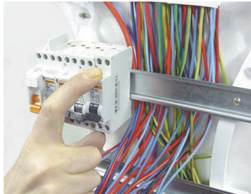
9 - Installez les protections sur les rails.
