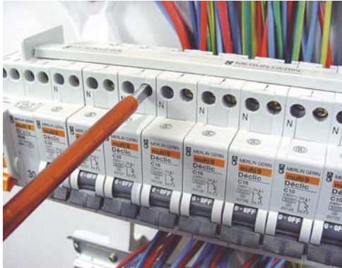
11 - Vissez fermement les vis des phases.
