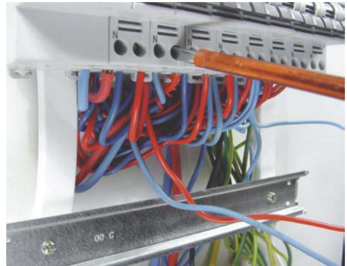
15 - Raccordez les lignes sous les protections.
